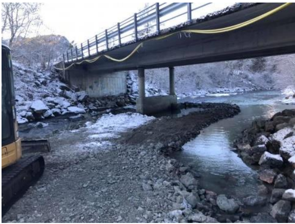
Arbeid ved Børset bru
