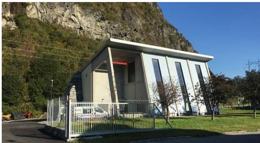
Bilde: Nytt vannverk i Hovsveien, åpnet høsten 2017
