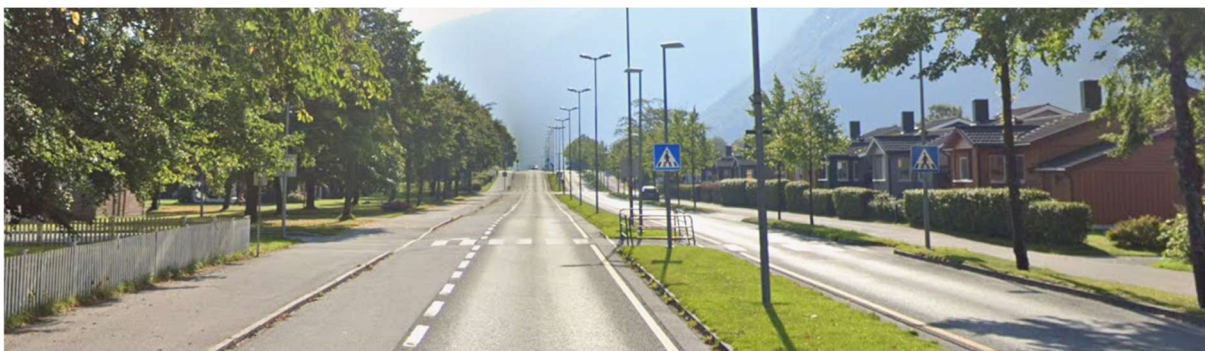
Figur 26 Utsikt oppover Sunndalsvegen. På venstre side mot helsetunparken er det fortau og sykkelfelt. På andre sida av Sunndalsvegen er det anlagt grøntrabatter som skiller kjørevegen fra en separat gang- sykkelveg
