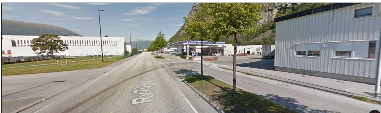
Figur 16 viser bilde fra krysset, og hvordan det er opparbeida, med ei trafikkøy (til høyre) som hindrer store biler.
