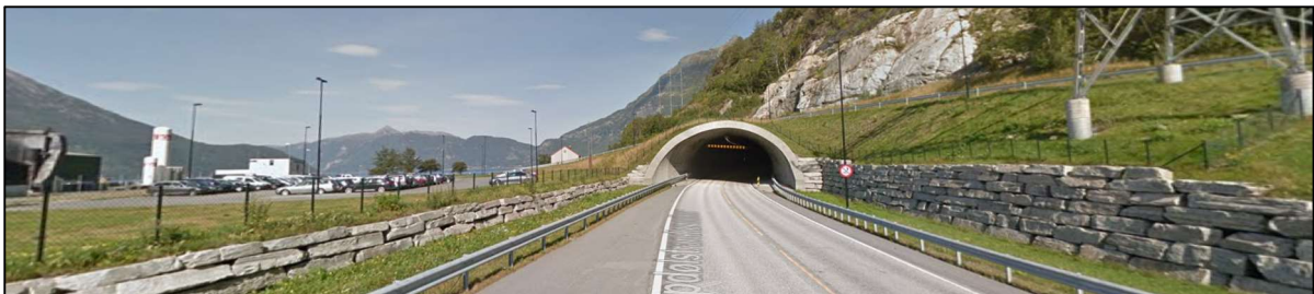
Figur 4 viser tunnelinnslaget på Rv 70, dagens parkeringsplass ved Hydro til venstre, og vi skimter tilkomstvegen til Fjordparken over tunnelinnslaget til høyre (Kilde, Googlemaps)
