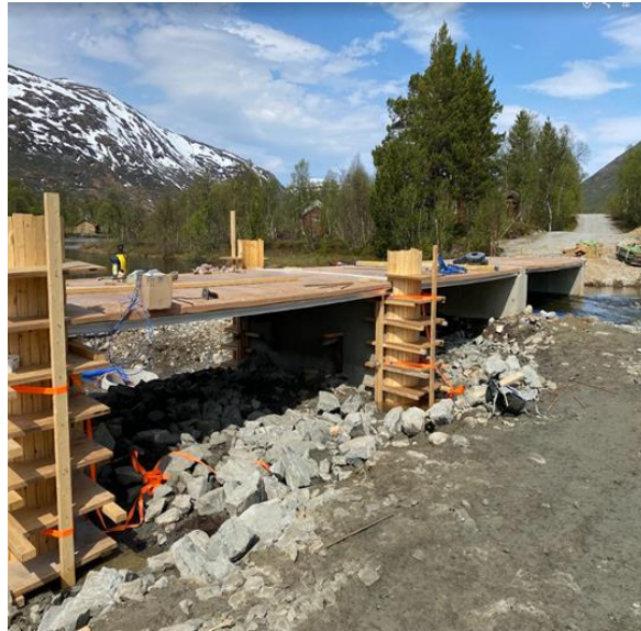
Bildet viser byggeprosessen av steinbrua i Grødalen, og er hentet fra Tekna.no .
