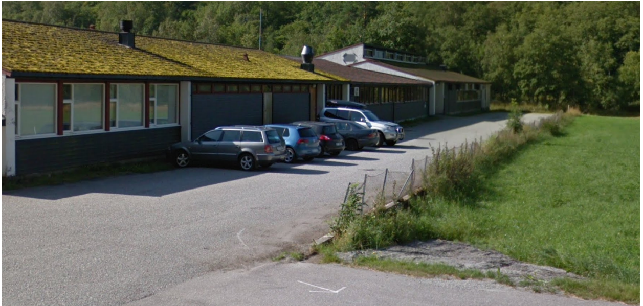
Foto av parkeringsplassen på nordsiden av Øksendal samfunnshus
