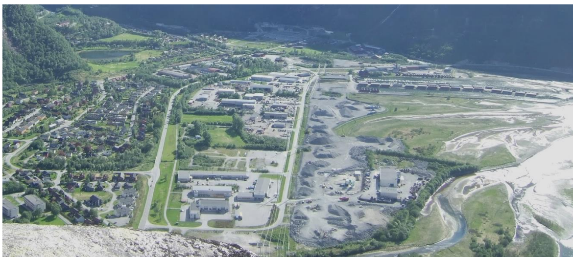
Figur 14. Deler av Håsørene og Sunndalsøra sett fra Flaggnuten i mai 2013. Massene fra Oppdølstrandtunnelen er stort sett kommet på plass. Foto: JBJ.
