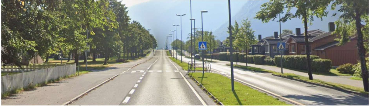
Figur 27 Utsikt oppover Sunndalsvegen. På venstre side mot helsetunparken er det fortau og sykkelfelt. På andre sida av Sunndalsvegen er det anlagt grøntrabatter som skiller kjørevegen fra en separat gang- sykkelveg
