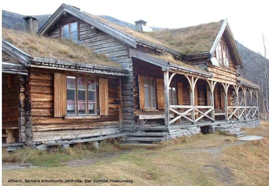
Alfheim, Barbara Arbuthnotts jaktlytte. Eier Sunndal Museumslag Alfheim er den første hytta Nordenfjells bygd kun for fritidsformål. Dagens form er fra 1890-tallet. Etelbert Lort-Phillips bygde på med svalgang og kjøkkendel.
