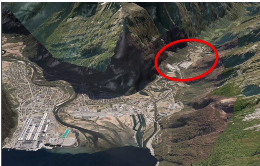
Grustaket sett fra flyhøyde (Norgeizd)
