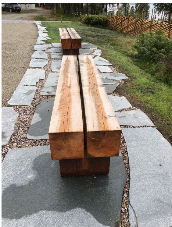
Bildeeksempler fra Elgå i Femundsmarka. Spesiellagede benker i malmfuru og cortenstål, skiferplass og kantstein.
