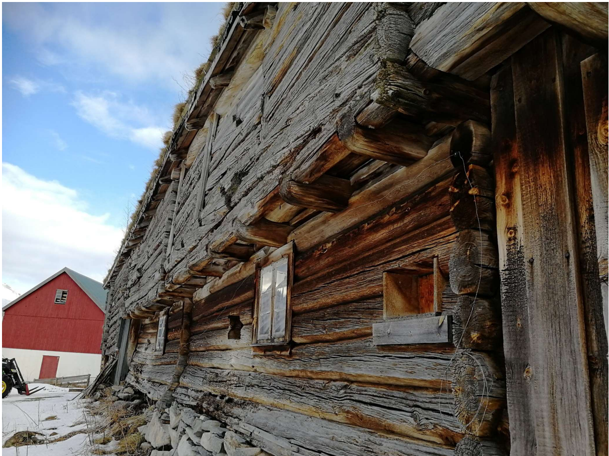
Figur 10: Fjøset på Pestua Børset på Ålvudneid har klare 1700-tallstrekk, slik som den utstikkende andre etasjen. Foto: Jarle Stavik, Nordmørsmusea.
