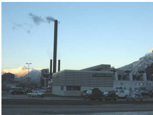
Varmesentralen til fjernvarmenettet til Sunndal Energi
