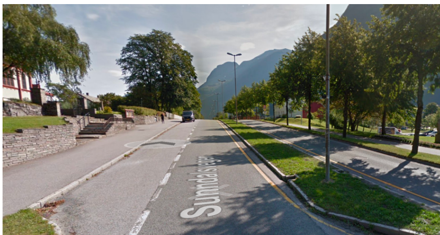
Figur 9 - Bil parkert på sykkelvei på Sunndalvegen i sentrum, utflytende areal og mangelfull markering av sykkelvei.
